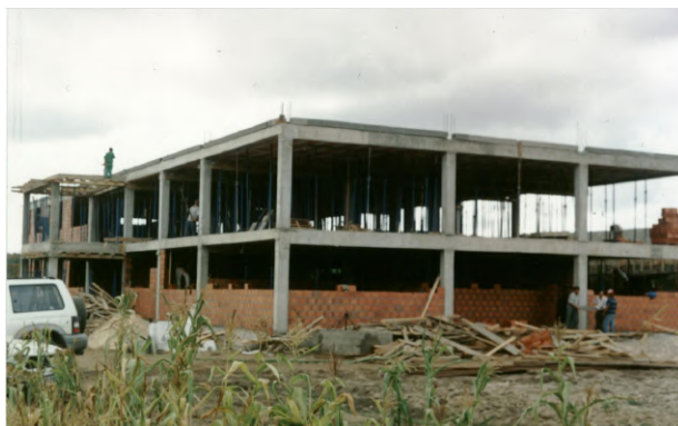
Fig. 1: Início da construção da Escola Pedro Teixeira
