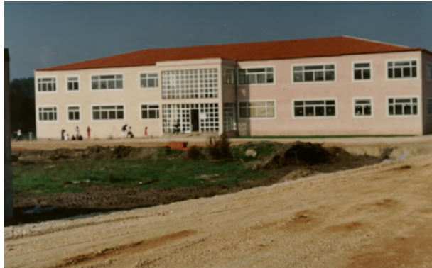
Fig 3: Edifício inicial da Escola Pedro Teixeira
